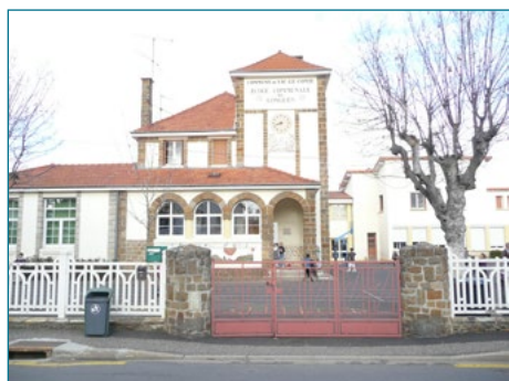
Nouvelle toiture à l'école M. Pagnol
