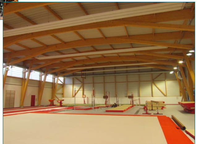
2012-2013 : Construction d'une nouvelle salle de gymnastique, au Complexe A. Boste.
