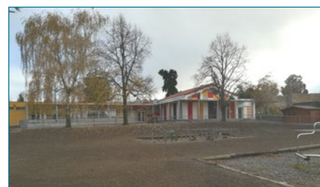
2018-2020 : Extension du restaurant scolaire et réhabilitation de l'école E. Triolet
